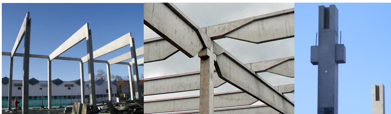
Obr. 3 Příklady možných řešení uložení vazníku na sloup v praxi [4]
