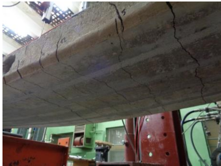
Obrázek 5: Trhliny po zničení referenčního panelu. ( jpg file )
