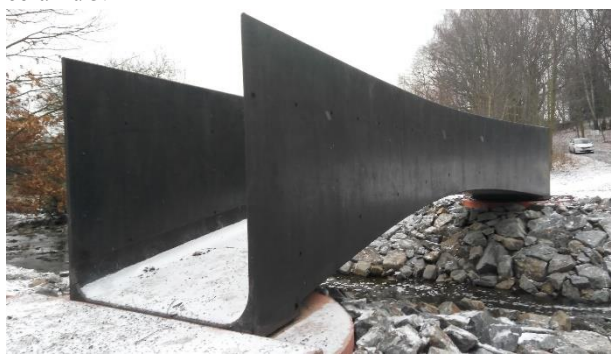
Obrázek 3: Dokončená lávka v Kladně - Vrapicích
