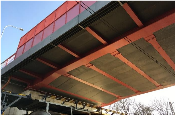
Obrázek 4: UHPFRC desky ztraceného bednění říms a mostovky
