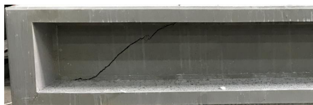
Obr. 9: Analýza módu poškození; foto porušeného vzorku
