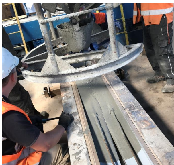
Obr. 5: Betonáž nosníku na předpínací dráze
