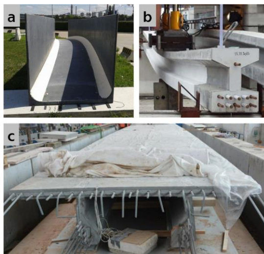
Obrázek 1: Tenkostěnné konstrukce z UHPC: a) prefabrikovaná lávka průřezu U (KŠ Prefa); b) předpjatý nosník, tloušťka stojiny 38 mm (Pontex & Skanska); c) dvouvrátová lávka v obci Čeperka, mostovka tloušťky 50 mm (Pontex & Skanska)
