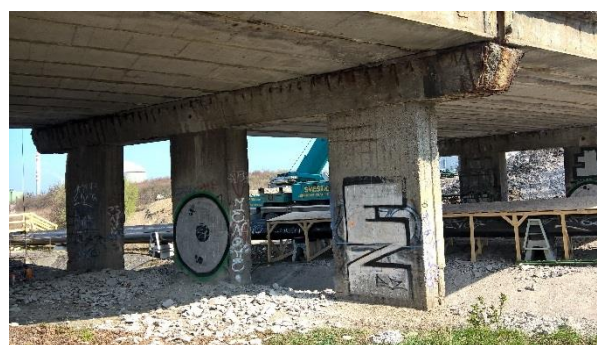
Obrázek 3: Mostní konstrukce, ze které byly odebrány vzorky
