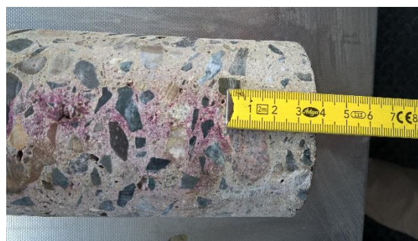
Obrázek 4: Výsledek experimentálního stanovení hloubky karbonatace
