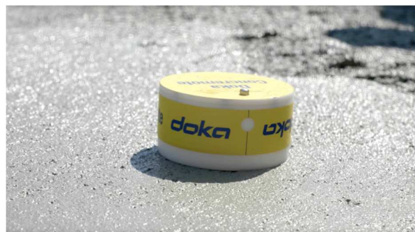
Obrázek 6: Osazený stropní senzor na právě uloženém betonu
