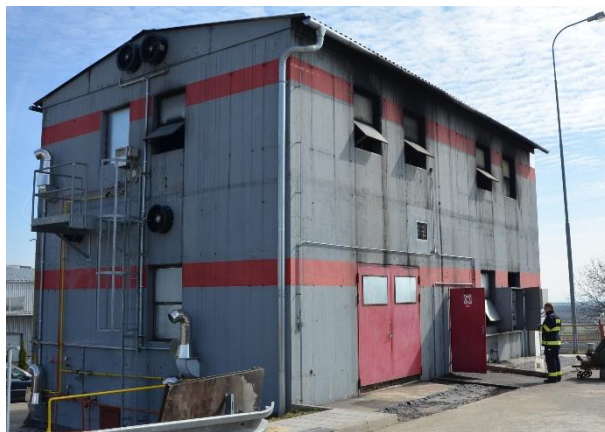
Obrázek 1: Objekt ohněvého domu (Procházka a kol., 2019).
