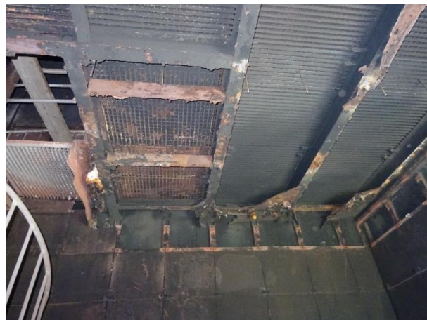
Obrázek 5: Neventilovaný ocelový strop 1.NP po odstranění podhledů (Procházka a kol., 2019).
