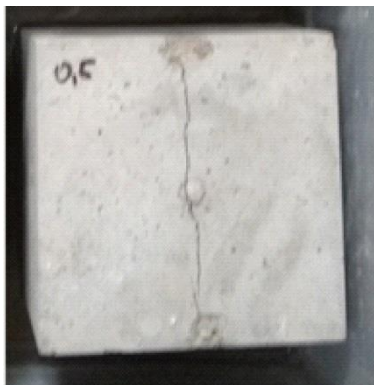
Obrázek 3: Zkušební krychle s trhlinou šíře 0,5 mm (Žáková a Žák. 2019).
