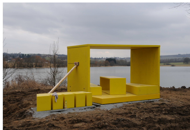
Obr. 02: Konstrukce cyklopointu při montáži
