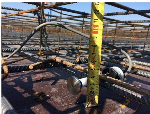
Obrázek 4: Umístění tenzometrů ve stropní desce.
