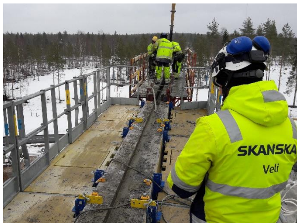
Obrázek 7 - Betonáž stěny s použitím vytápěného stěnového bednění, Finsko [Foto: Autor]
