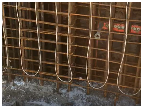
Obrázek 2 - Vytápění betonu elektrickými odporovými kabely, Polsko [Foto: Ivan Beliatski]
