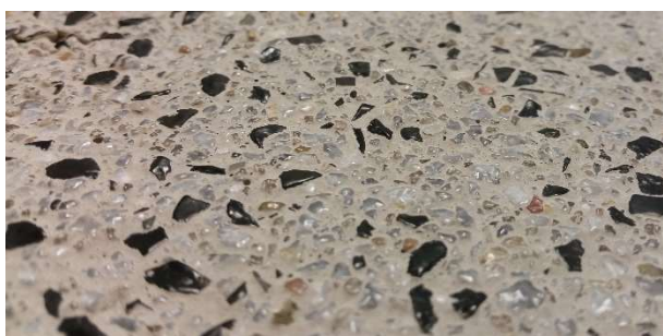
Obrázek 4: Úprava betonu kartáčováním
