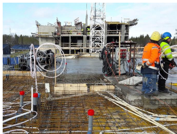
Obrázek 9 - PE pěnová fólie (vlevo), stavební elektrický rozvaděč - důležitá součást staveniště při použití vytápěného bednění (vpravo), Finsko [Foto: autor]
