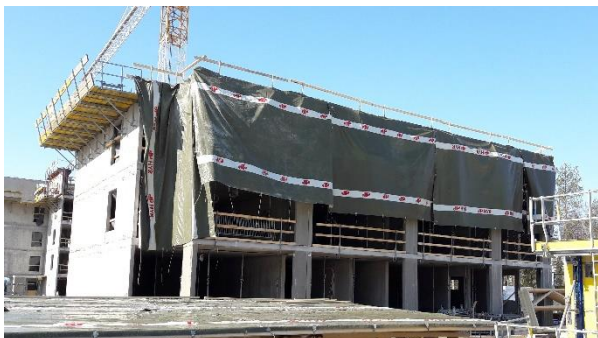
Obrázek 3 - Zakrytí okenních otvorů v podlaží, kde je umístěno vytápění, Finsko [Foto: Autor]
