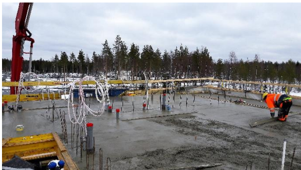
Obrázek 4 - Dokončování betonářských prací, Finsko [Foto: Autor]
