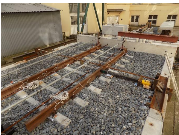
Obrázek 1: Model bezстыkové koleje při měření kolejevého roštu v příčném směru
