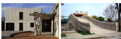
Obr. 8: 3D tištěný sloup v Aix-en-Provence, 2019
