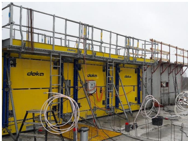
Obrázek 6 - Vytápěné stěnové bednění, Finsko [Foto: Autor]
