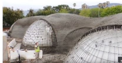
Obr. 12: Pneumatikové bednění firmy Bibishell
