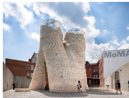
Obr. 16: Umělecká expozice postavená z cihel z biomasy zpevněné podhoubím
