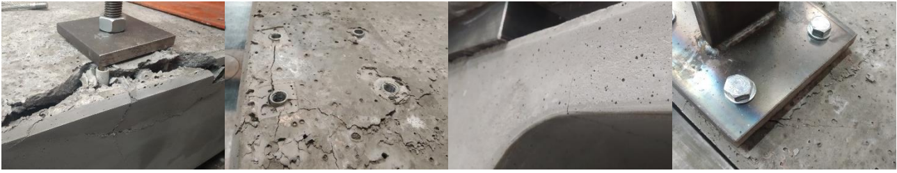
Obrázek 6: Detail porušení při- pravku X – zkouška 5A
