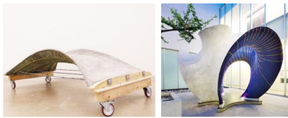
Obr. 14: Betonové prvky vytvořené pomocí pletného bednění
