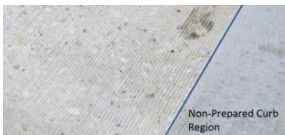
Obrázek 4: Zbroušený a očištěný povrch betonu pro správné propojení vrstev [4]
