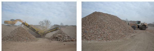
(c) Třídění stavební suti na různé frakce. (d) Skladování roztříděné stavební suti na deponii.
