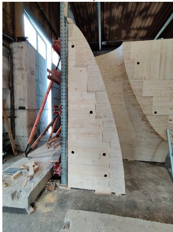
Obrázek 9: Kontrolní montáž bednicí formy v areálu prefabrikace bednění SMP CZ a.s. - PIM Beroun
