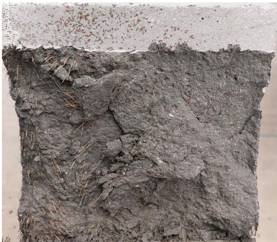
Obrázek (1) – lomová plocha drátkobetonového vzorku
