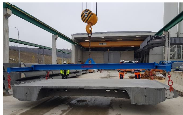
Obrázek 5: Segment při manipulaci na skládce
