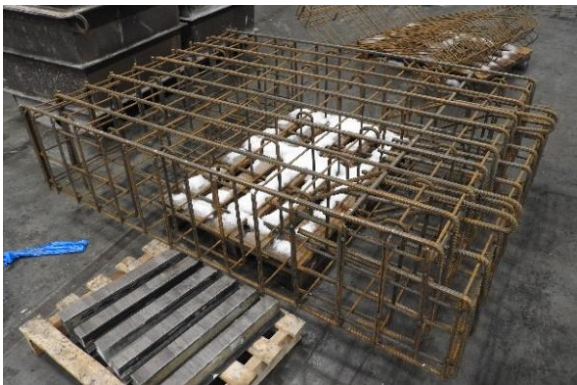
Obrázek 2: Vyzávaná výztuž zkušební tělesa
