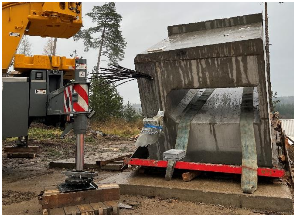
Obrázek 7: Zkušební lamela po odbednění
