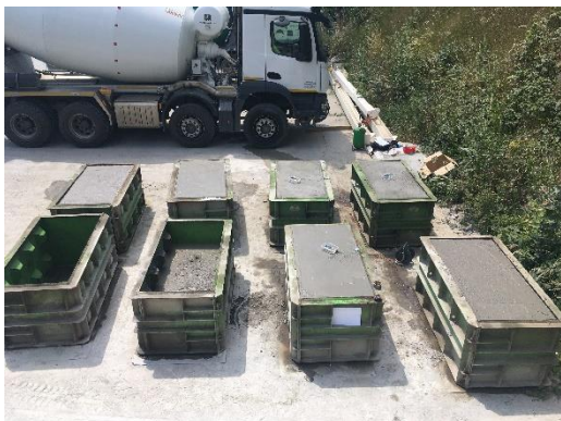
Obrázek 4: Zkušební betonové bloky – po betonáži
