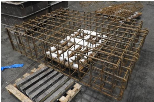
Obrázek 4: Vyzvázaná výztuž zkušební tělesa (Betonové stavby – group, Klatovy)
