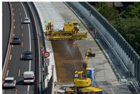
Obrázek 2: Pokládka UHPC finišerem (Ductal 2016)
