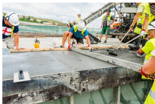
Obrázek 3: Pokládka UHPC na Barrandovském mostě (TBG Metrostav 2023)
