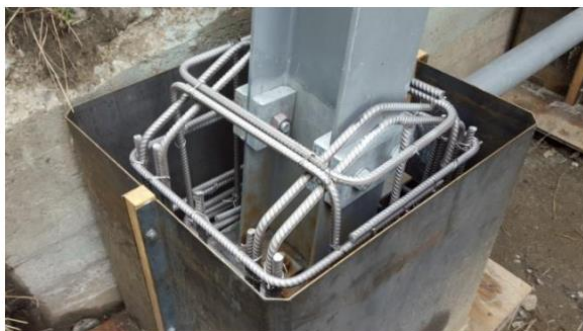
Obrázek 9: Vývýšení základu a projení výztuží (Doiron 2019)
