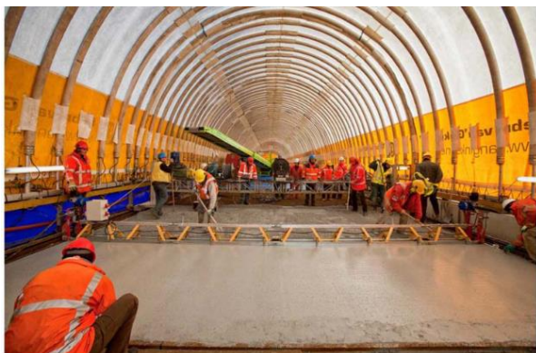
Obrázek 7: Betonáž UHPC pod ochranou (Buitelaar 2010)
