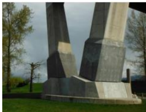
Obrázek 8: Pata pilíře po provedení zesílení (Doiron 2019)
