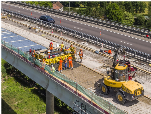
Obrázek 7: Ukládání UHPFRC na Pont d'Ouche ve Francii [afgc.asso.fr]
