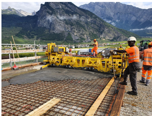
Obrázek 5: Ukládka UHPFRC na mostě Riddes [vigier-ciment.ch]
