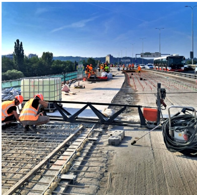
Obrázek 8: Probíhající rekonstrukce na Barrandovském mostě [barrandak.cz]
