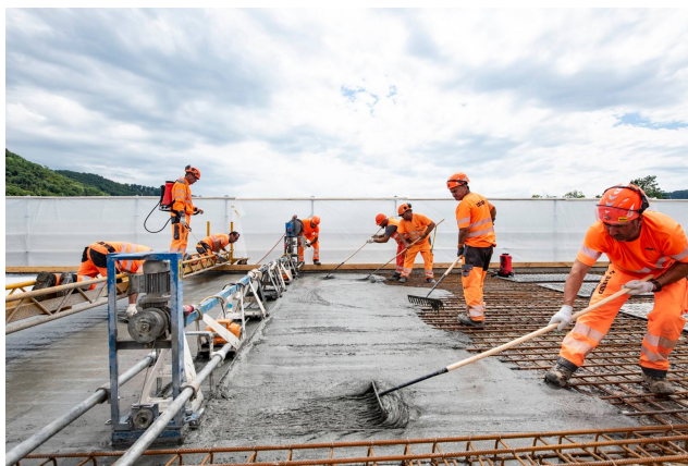
Obrázek 6: Ukládání UHPFRC na mostě Aare [kibag.ch]
