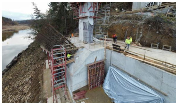
Obrázek 4: Foto velkého základu
