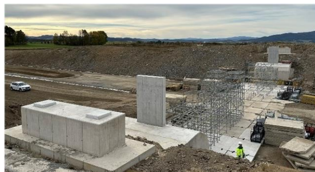
Obrázek 8: Dokončená spodní stavba mostu SO 212 [3]
