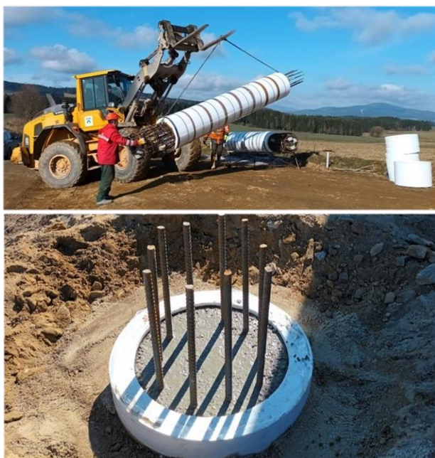
Obrázek 5: Piloty se ztraceným bedněním z EPS [3]
