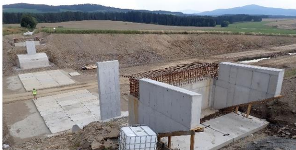
Obrázek 6: Dokončená spodní stavba mostu SO 209 [3]
