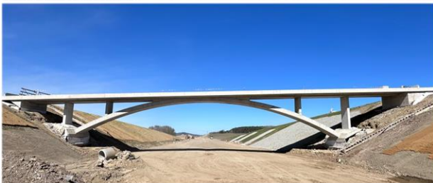
Obrázek 9: Most SO 209 během výstavby nosné konstrukce
