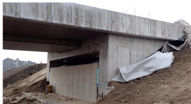
Obrázek 7: Semiintegrování zakončení mostu SO 212 [3]
