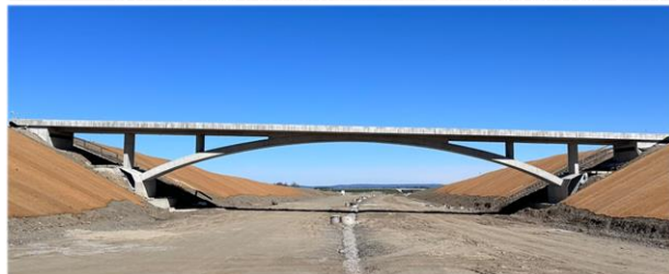
Obrázek 10: Most SO 212 Během výstavby nosné konstrukce
