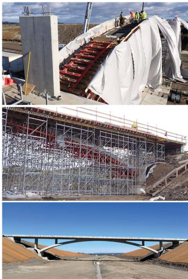
Obrázek 10: Most SO 212 Během výstavby nosné konstrukce
