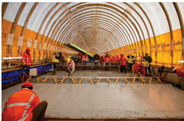
Obrázek 7: Betonáž UHPC pod ochranou (Buitelaar 2010)
