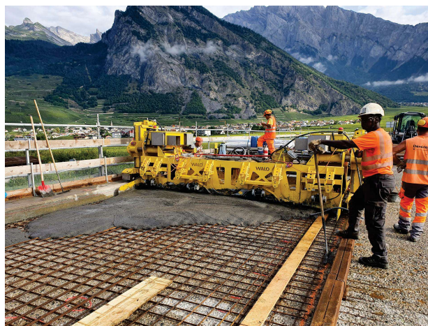
Obrázek 5: Ukládka UHPFRC na mostě Riddes [vigier-ciment.ch]
