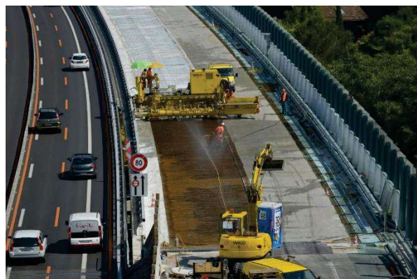
Obrázek 2: Pokládka UHPC finišerem (Ductal 2016)
