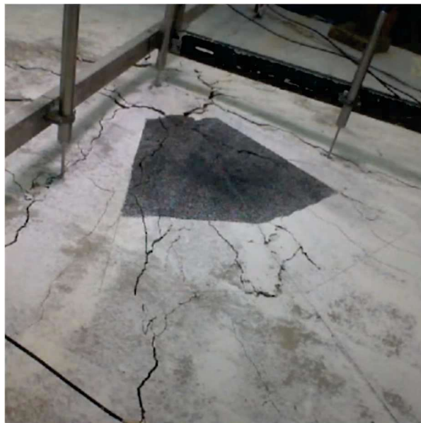
Obr. 04: Detail trhlin desky 1 – viditelné poškození v blízkosti lokálního zatížení [5]
