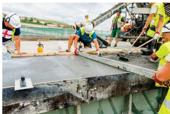
Obrázek 3: Pokládka UHPC na Barrandovském mostě (TBG Metrostav 2023)
