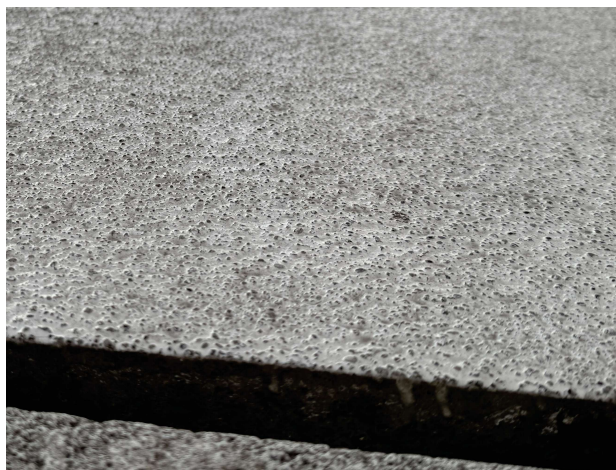
Obrázek 1: Detail povrchu prefabrikátu s protiskluznou úpravou použitým na Štvanické lávce v Praze [archiv autora]
