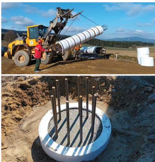
Obrázek 5: Piloty se ztraceným bedněním z EPS [3]
