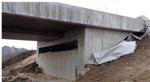
Obrázek 7: Semiintegrované zakončení mostu SO 212 [3]
