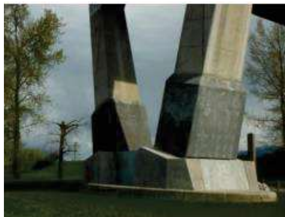
Obrázek 8: Pata pilíře po provedení zesílení (Doiron 2019)
