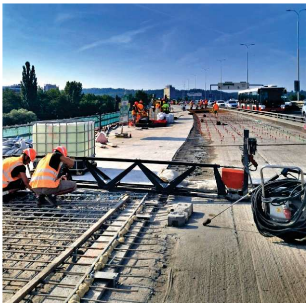
Obrázek 8: Probíhající rekonstrukce na Barrandovském mostě [barrandak.cz]
