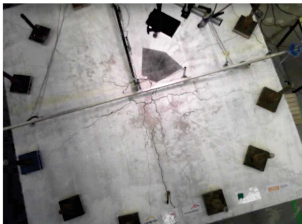
Obr. 03: Rozvoj trhlin na horním taženém povrchu drátkobetonové desky 1 [5]
