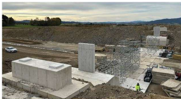
Obrázek 8: Dokončená spodní stavba mostu SO 212 [3]
