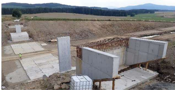
Obrázek 6: Dokončená spodní stavba mostu SO 209 [3]
