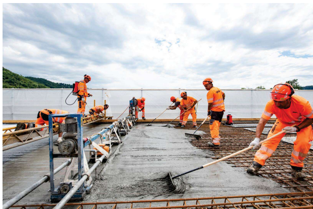
Obrázek 6: Ukládání UHPFRC na mostě Aare [kibag.ch]
