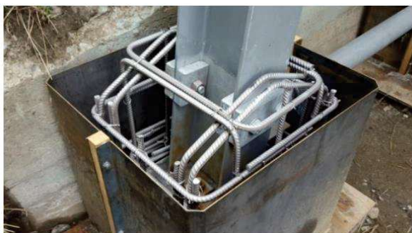
Obrázek 9: Vývýšení základu a projení výztuží (Doiron 2019)
