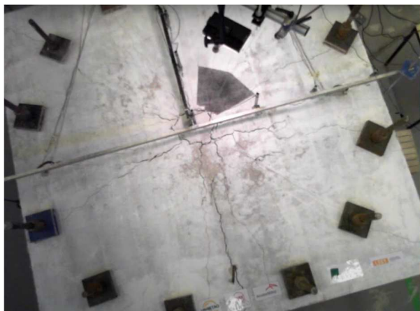
Obr. 03: Rozvoj trhlín na horním taženém povrchu drátkobetonové desky 1 [5]
