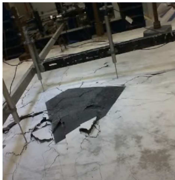
Obr. 05: Detail trhlín desky 2 – nesymetrické poškození [5]
