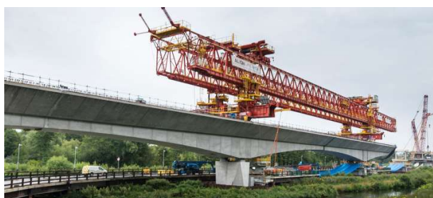
Obrázek 11: Colne Valley viaduct během výstavby [7]
