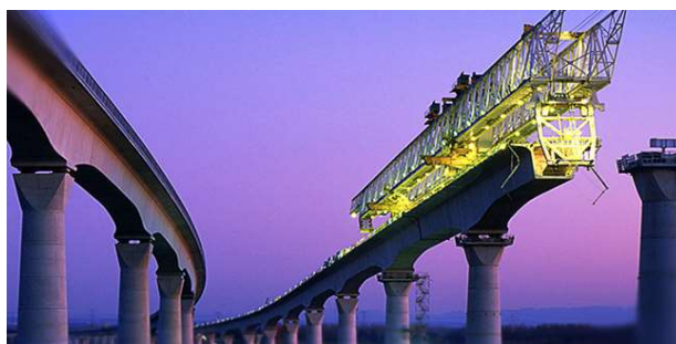
Obrázek 10: Segmentové viadukty u města Avignon [5]
