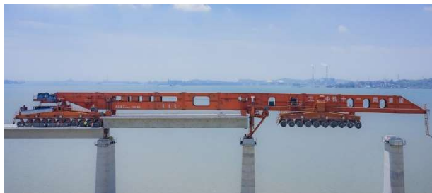
Obrázek 9: Výstavba metodou těžké prefabrikace [4]
