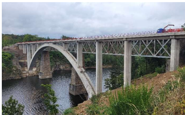
Obrázek 6: Obloukový železniční most u obce Červená
