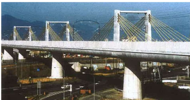
Obrázek 8: Extradosed železniční most v Japonsku [3]
