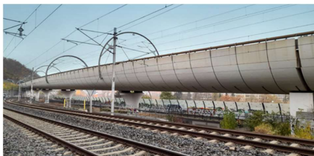
Obrázek 5: Železniční estakáda Sluncová v Praze [1]
