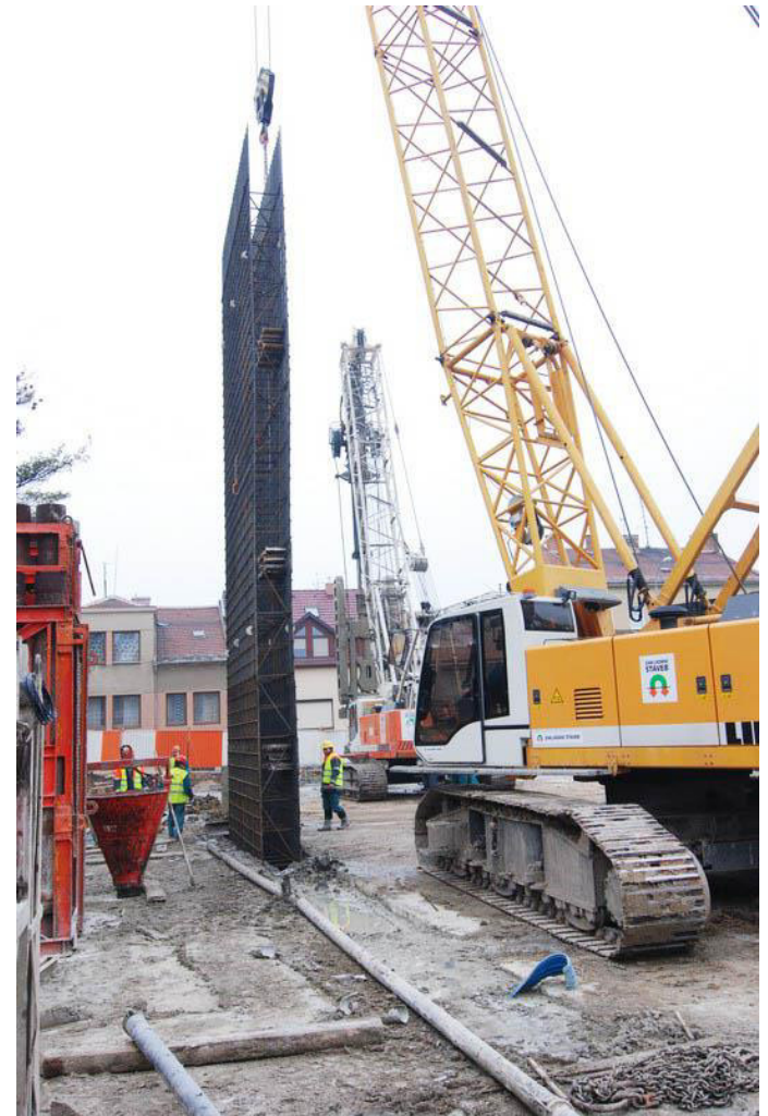
Obr. 15.: Vložení armokoše
