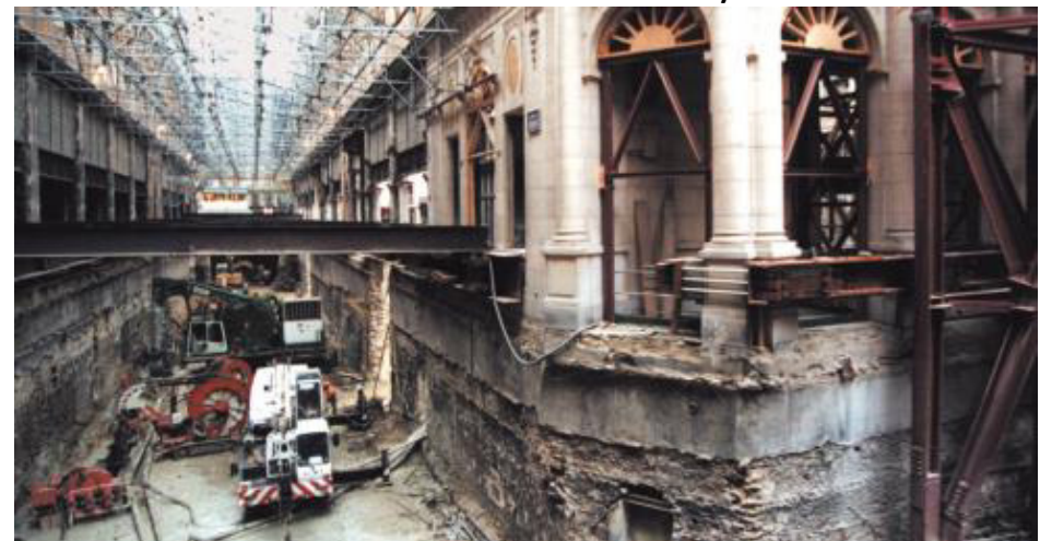
Obr. 19.: Podzemní stěny pažící a konstrukční
