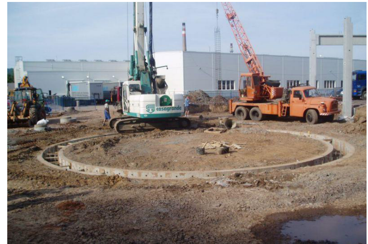
Obr. 11.: Vodící zídky
