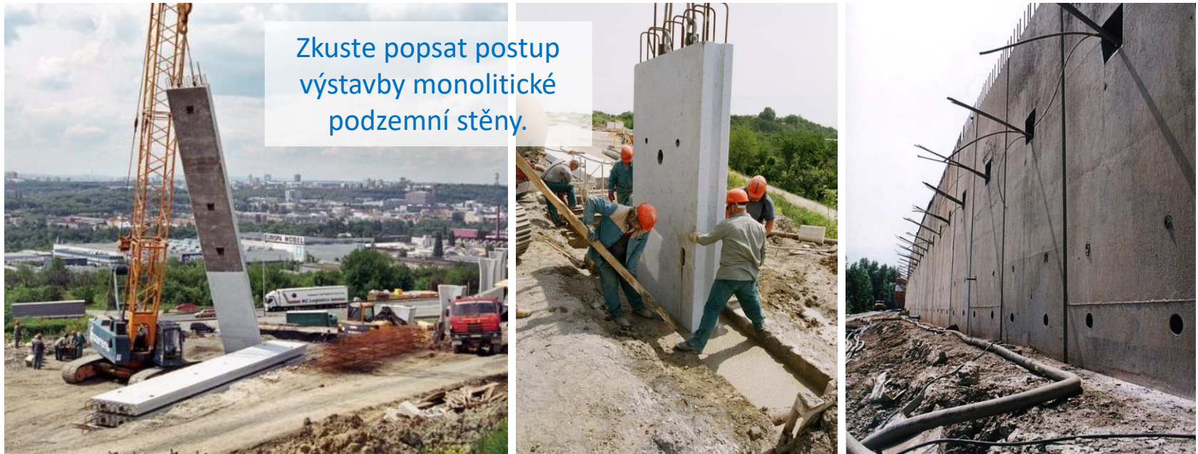
Obr. 10.: Prefabrikovaná podzemní stěna
