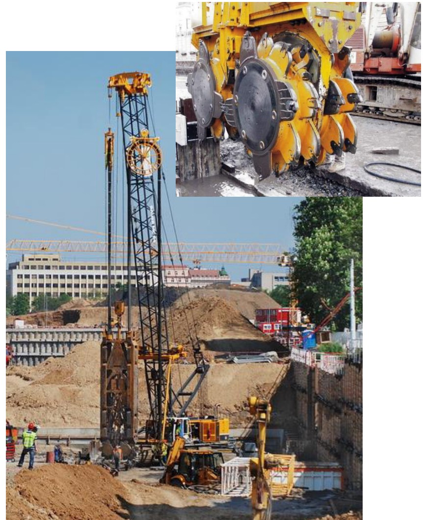
Obr. 12.: Těžba rýhy drapákem (vlevo) a frézou (vpravo)
