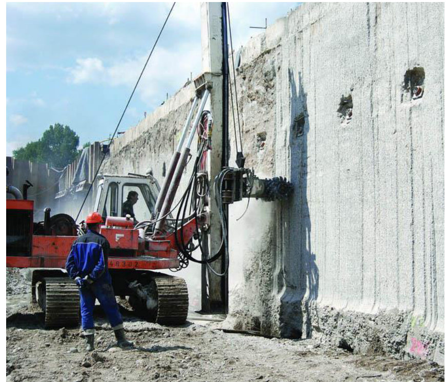
Obr. 17.: Provedení úpravy povrchu monolitické podzemní stěny
