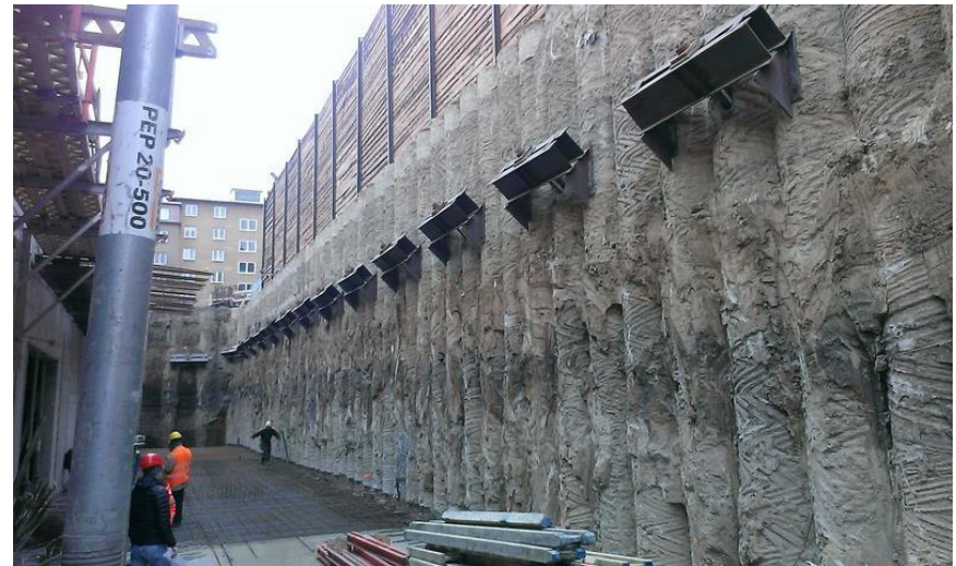
Obr. 5.: Pilotové stěny
