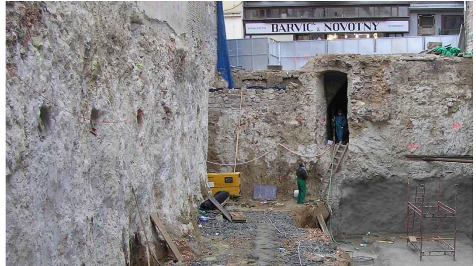
Obr. 7.: Stěny z tryskové injektáže
