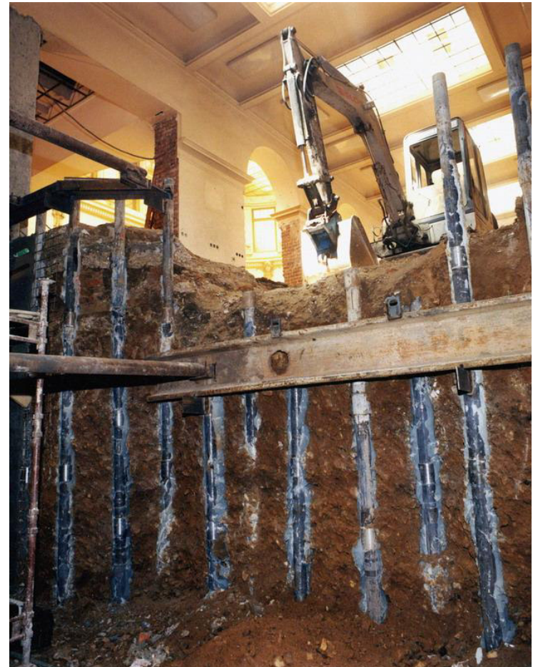
Obr. 6.: Mikrozáporové stěny
