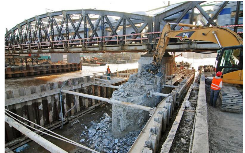
Obr. 4.: Štetovnicové stěny
