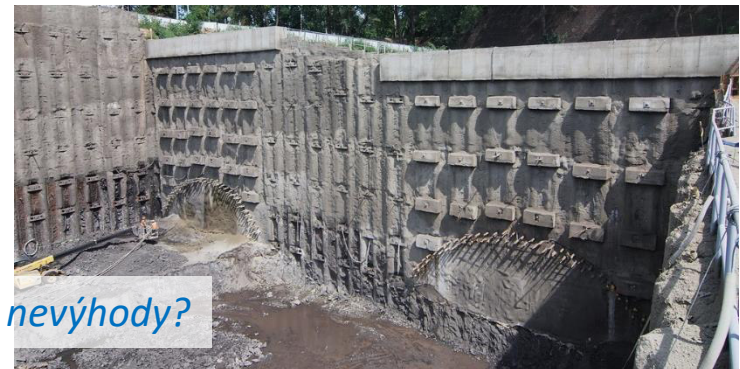
Obr. 2.: Svahovaná (vlevo) a pažená (vpravo) stavební jáma
