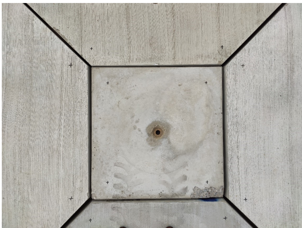
Obr. 12 Styk dílců před spárováním
