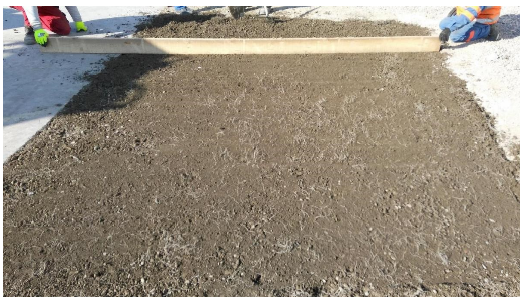
Obr. 10 Vrstva vláknobetonu s plnou náhradou přírodního kameniva
