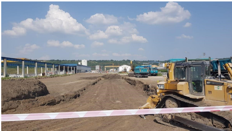
Obr. 2 Obnažení zemní pláně
