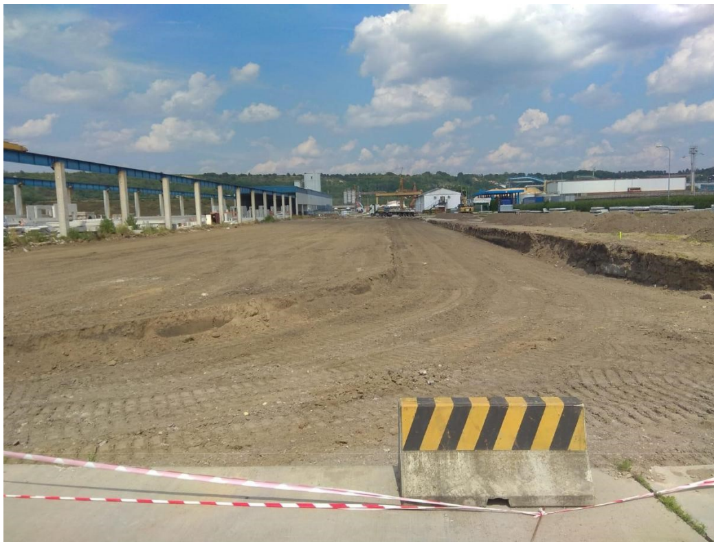
Obr. 8 Zemní pláň před začistěním
