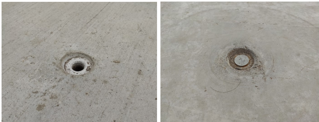
Obr. 7 Pouzdro pro uchycení kotvy (vlevo) včetně zátky (vpravo)
