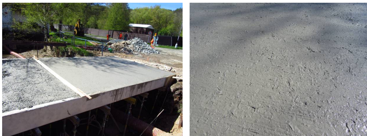
Obr. 6 Vlevo vyrovnavání povrchu pomocí profilovaného prkna. Vpravo povrch čerstvého vláknobetonu po provedení striáže.
