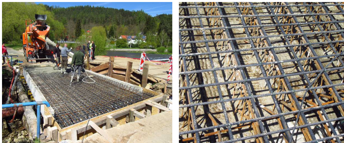
Obr. 5 Vlevo celkový pohled na most před zhotovením monolitické dobetonávky z vláknobetonu. Vpravo detail výztuže, horní výztuž desky je opatřena ochranným termoplastickým povlakem.
