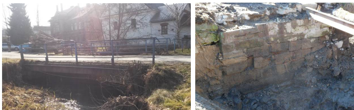
Obr. 2 Původní konstrukce. Vlevo boční pohled na most, vpravo opěrná zeď po odstranění mostu.
