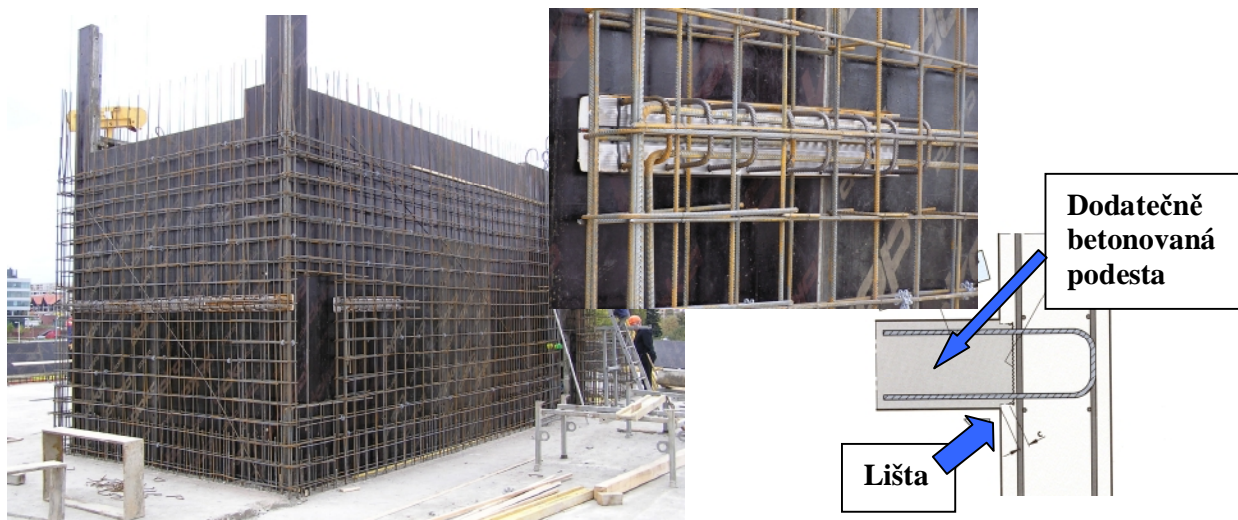
Obr. 16 Vylamovací lišty vkládané do bednění schodišťových stěn pro uložení mezipodesty
