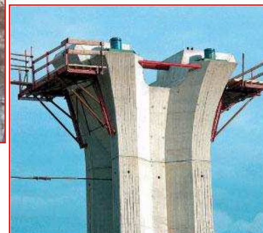
Provizorní podpory (hydraulické lisy) na hlavici piliřů mostu přes Uhlavu na D5
