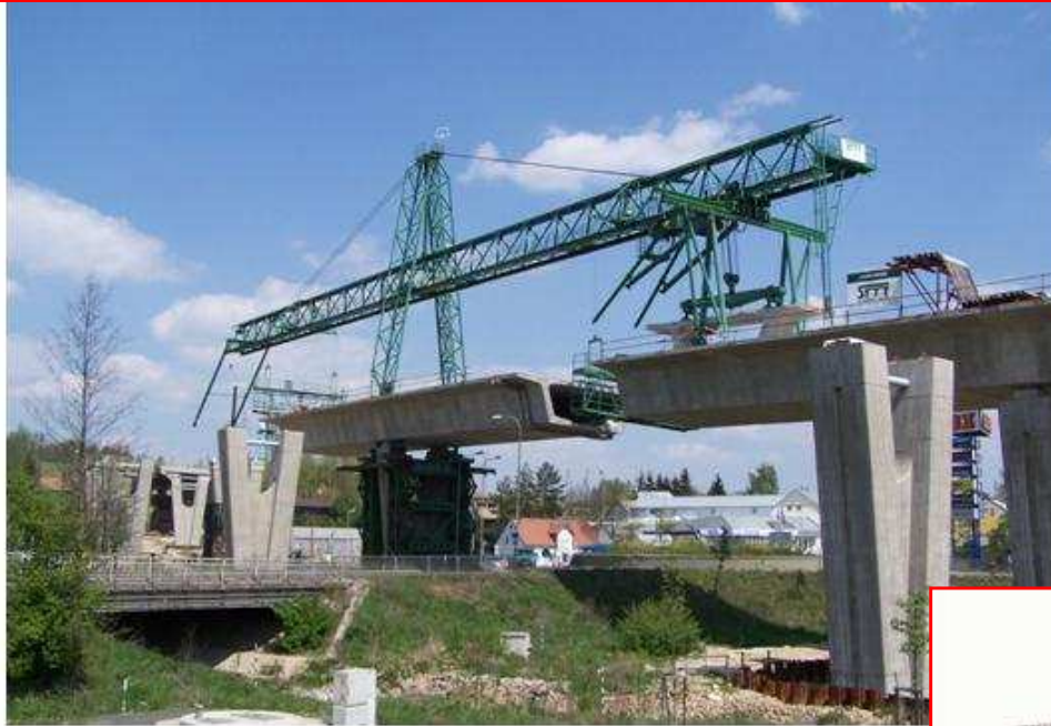
Montáž vahadla na montážních podporách
