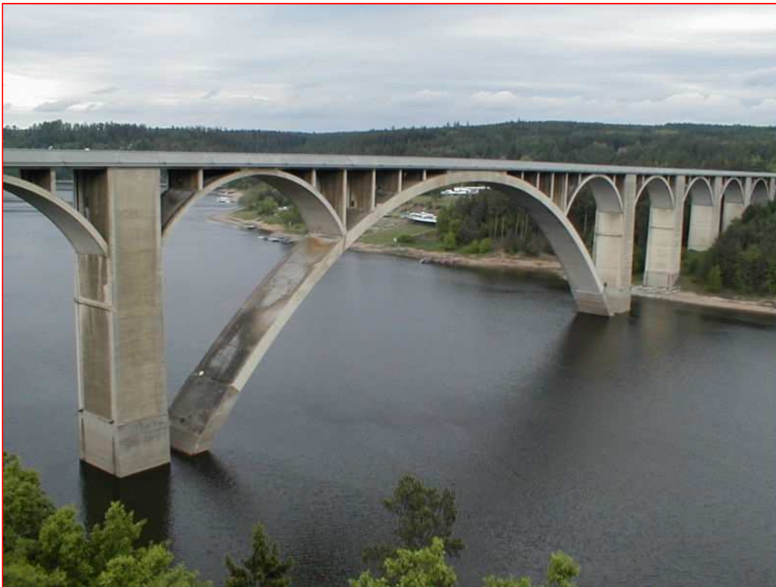
Most přes Vltavu u Podolska (1941, rozpětí 150 m)
