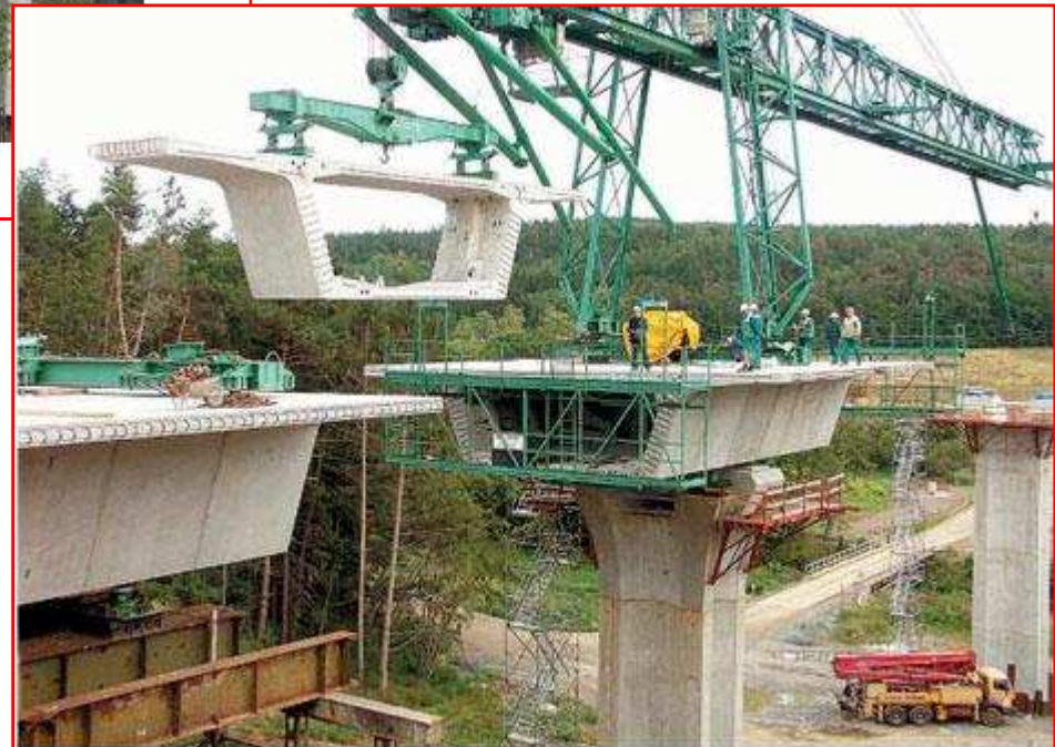
Montáž běžného vahadla (most přes Úhluvu na D5)
